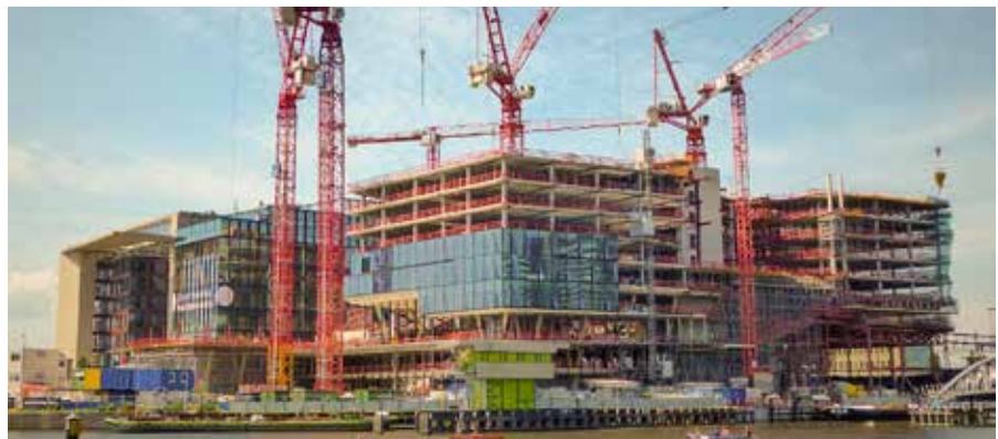
De werkzaamheden zijn in volle gang.
